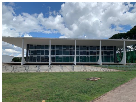
Figura 2 – Fachadas do STF parcialmente recuperadas (vidros substituídos e pichações retiradas)
