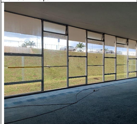
Figura 33 – Salão Azul, fachada envidraçada com vidros substituídos
