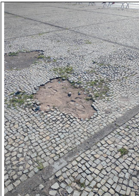
Figura 1 – Praça dos Três Poderes - área do piso em pedra portuguesa limpo, mas ainda sem reconstituição do revestimento
