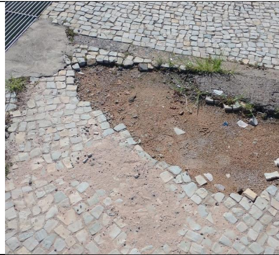
Figura 5 – Praça dos Três Poderes – trecho do piso danificado, com reconstituição ainda pendente
