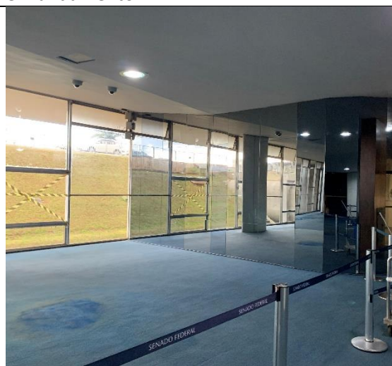
Figura 34 – Salão Azul, fachada envidraçada com vidros substituídos, carpete ainda
