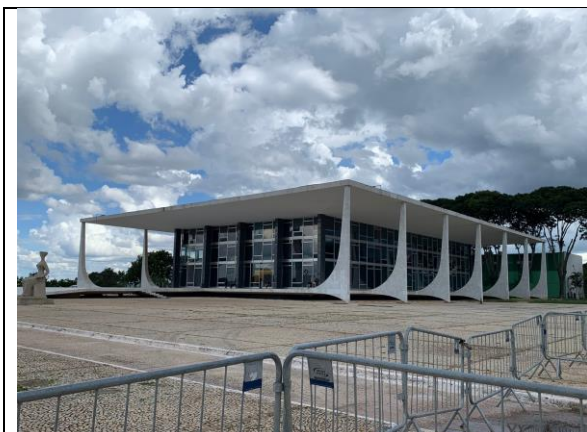
Figura 1 – Fachadas do STF parcialmente recuperadas (vidros substituídos e pichações retiradas)
