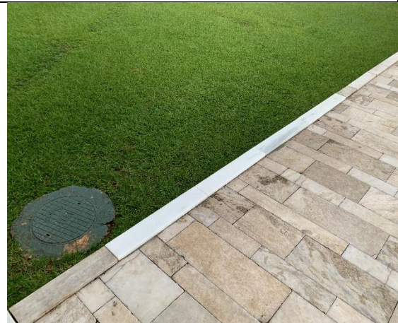
Figura 47 – Peças de mármore substituídas na rampa de acesso à cobertura do edifício principal
