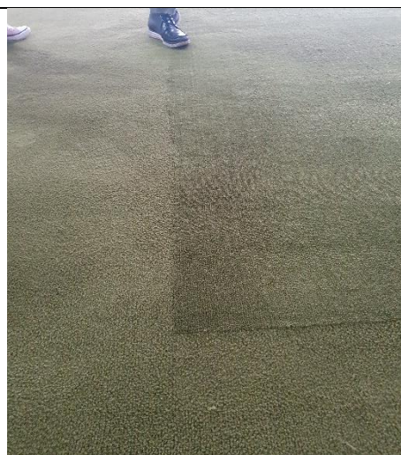
Figura 18 – Detalhe de trecho do carpete substituído
