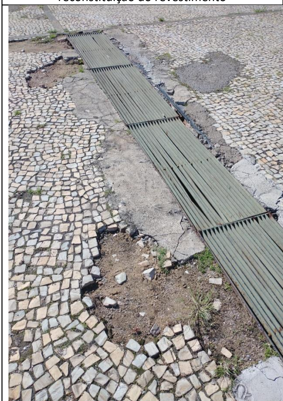
Figura 1 – Praça dos Três Poderes - área do piso em pedra portuguesa limpo, mas ainda sem reconstituição do revestimento
