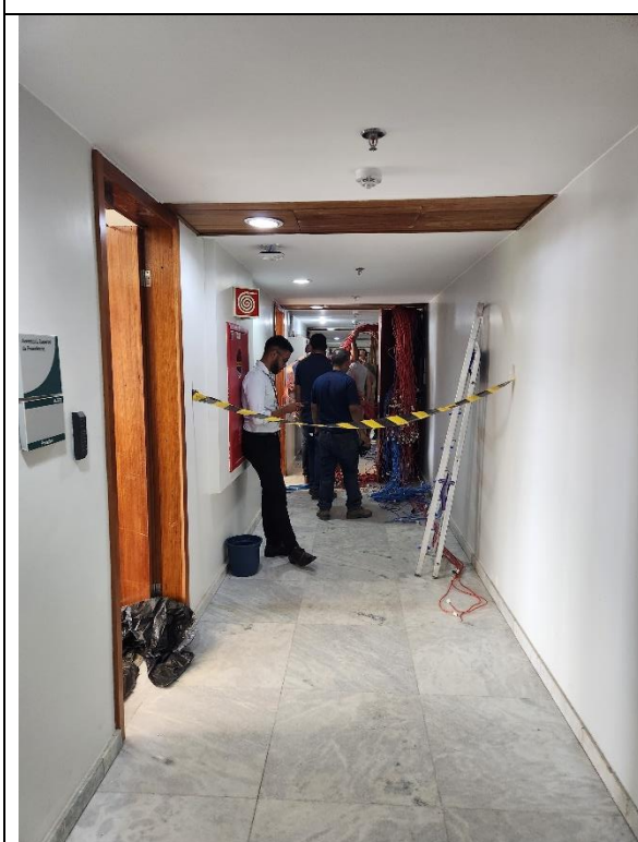
Figura 23 – Equipe do STF trabalha na recuperação e modernização do sistema elétrico
