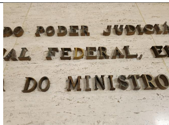
Figura 12 – Letreiro provisoriamente recomposto com peças em acrílico (observar letra “D”). As peças definitivas estão sendo produzidas
